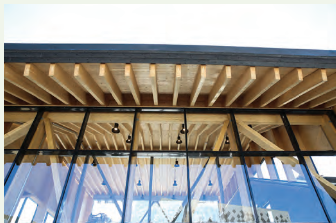
H-fasader har levert glassfasaden på fjordstasjonen. Splitkon i Åmot har levert elementer i massivtre og limtre.
