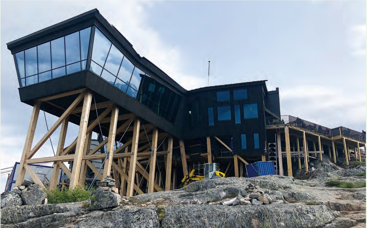
Det som gjorde den korte byggetiden mulig på et krevende anlegg uten veiforbindelse til toppen, er at byggene i størst mulig grad er levert som byggesett med stål, limtre og massivtrelementer. Foto: Arve Brekkhus
