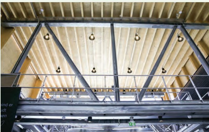
Den lokale mekaniske bedriften ProCut i Isfjorden har levert stålkonstruksjoner til Romsdalsgondolen. Her fra fjordstasjonen.
