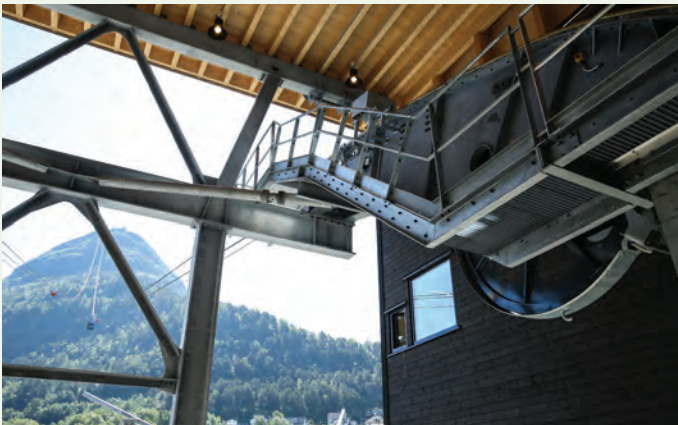
Det som gjorde den korte byggetiden mulig på et krevende anlegg uten veiforbindelse til toppen, er at byggene i størst mulig grad er levert som byggesett med stål, limtre og massivtrelementer. Foto: Arve Brekkhus
