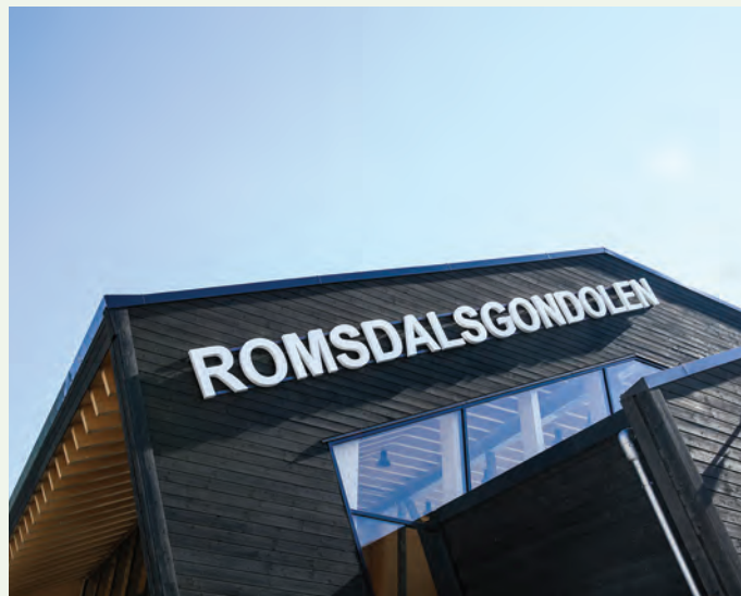
Fjordstasjonen er satt sammen av elementer i massivtre og limtre.
