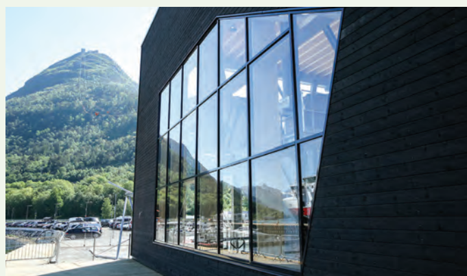
H-fasader har levert glassfasader til Romsdalsgondolen. Fasaden består ellers av værbestandig trekledning.
