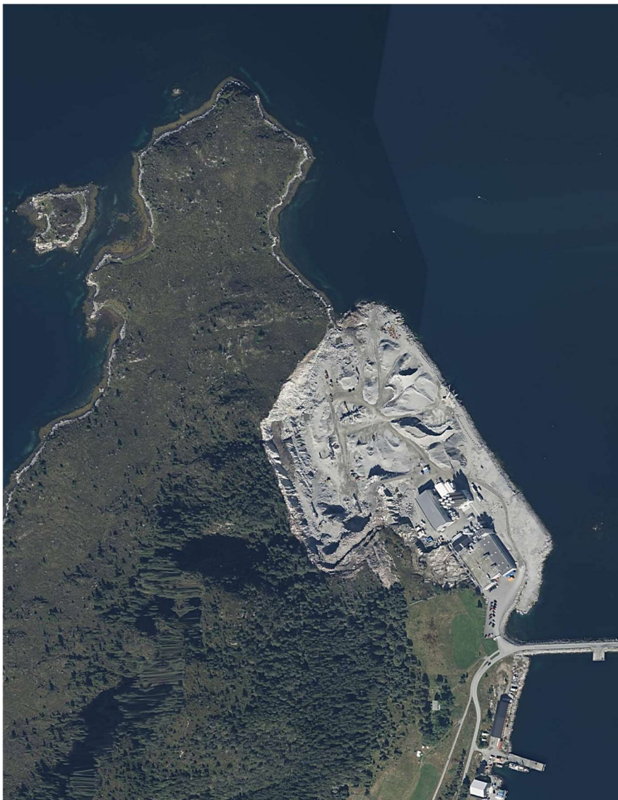
Fig. 3 Flyfoto som viser dagens situasjon.
